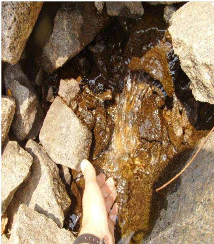
BARRAGEM DE CUAMBA – Ressurgência
