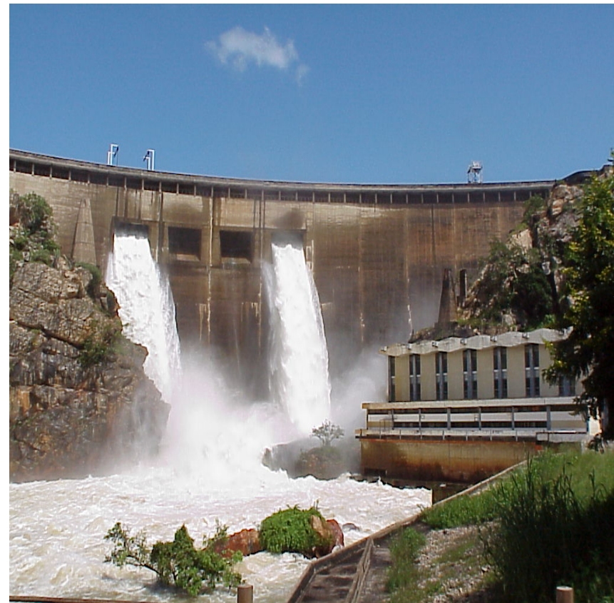
Central e Barragem da Chicamba
