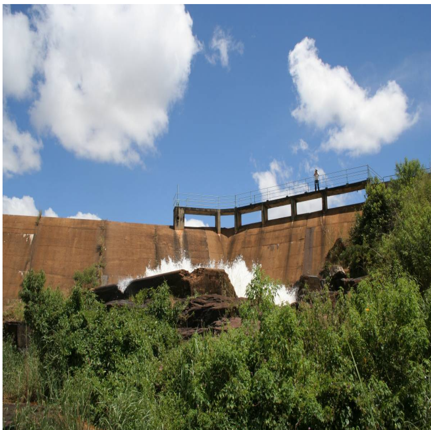
BARRAGEM DE LICHINGA – vista de jusante
