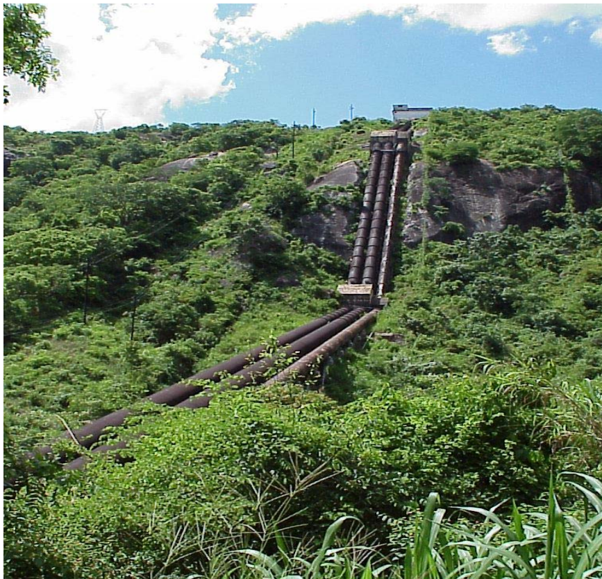
CENTRAL DE MAVUZI – condutas forçadas
