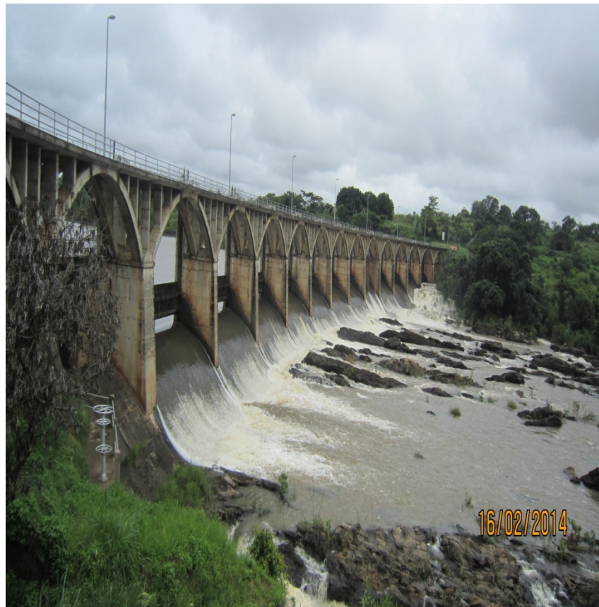
AÇUDE DE MAVUZI – vista de jusante
