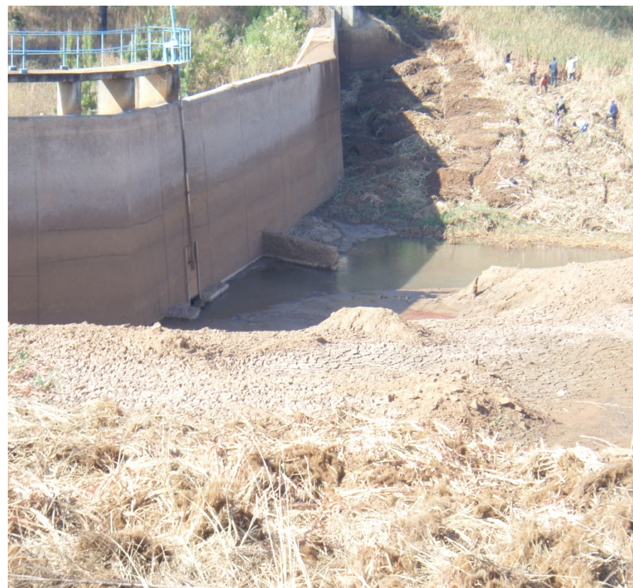
BARRAGEM DE LICHINGA – vista de montante
