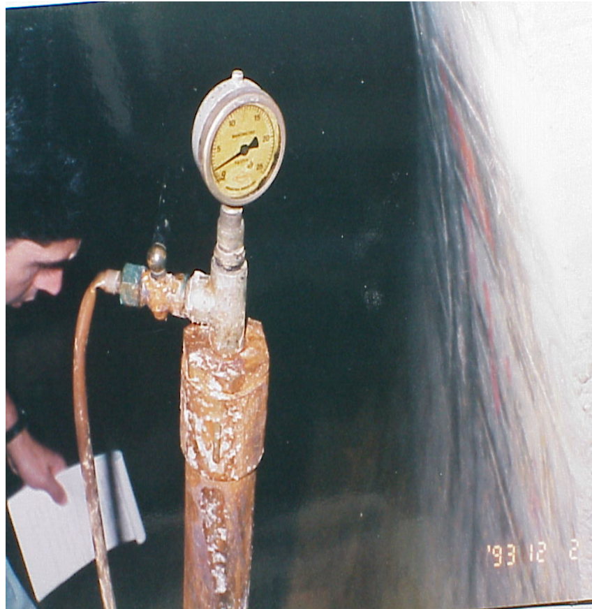
Piezómetro antes da reabilitação
