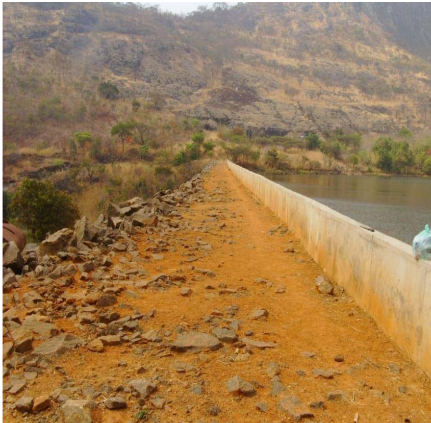
BARRAGEM DE CUAMBA – vista do coroamento
