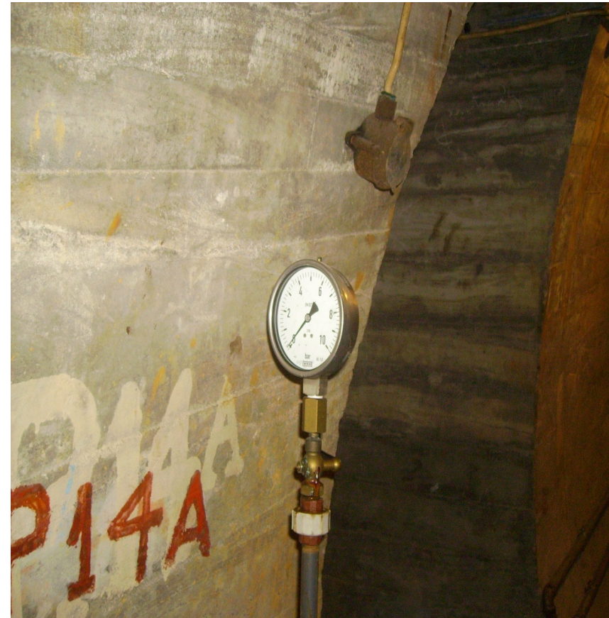
Piezómetro após reabilitação
